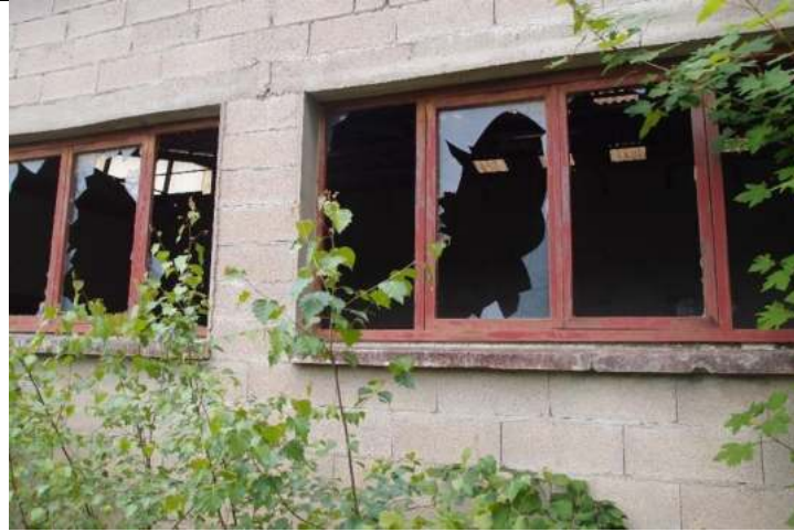
Figure 325 : Exemple de fenêtres du bâtiment pouvant être partiellement comblées
