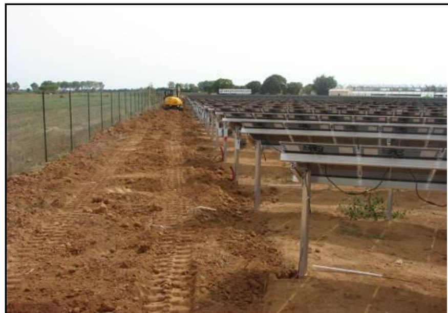
Figure 304 : Recouvrement des tranchées
